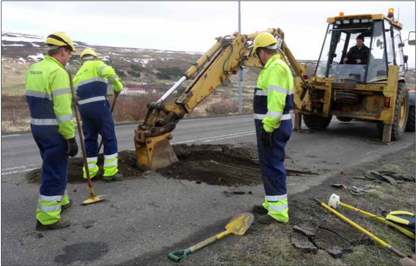
Hringvegur (1) í Reykjadal. Grafa þurfti rannsóknarholur í veginn til að meta malarefnið sem hann er byggður úr og burðarþol þess. Mynd: Hafdís Eygló Jónsdóttir 13.05.2014.
