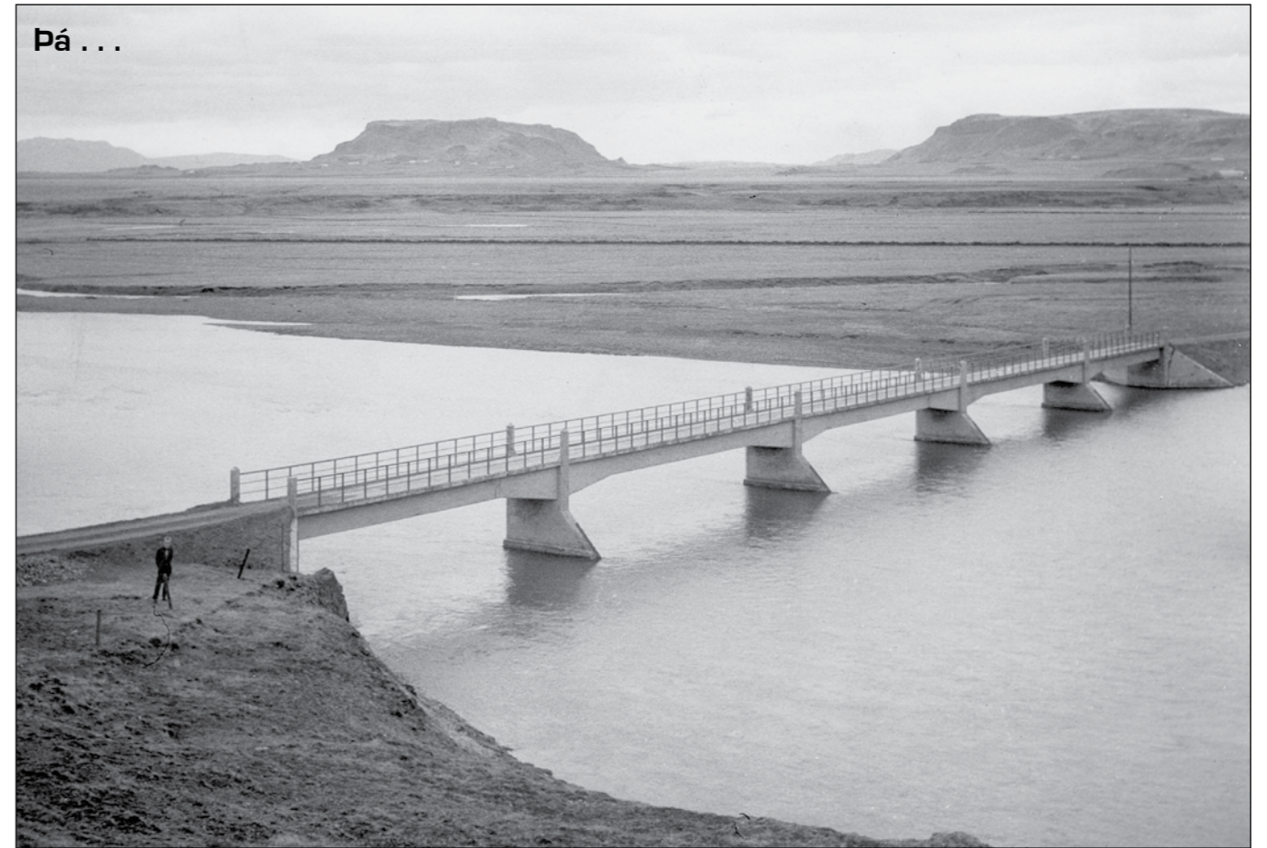
Stóra Laxá í Hreppum. Þessi brú var byggð 1929 og rifin 1985. Hún var 96,5 m löng, með tveimur landstöplum og fjórum stöplum í farveginum. Undir hverjum miðstöplanna voru 5 staurar úr járnbentri steypu og voru þeir reknir niður 2-4 metra niður á botn. Í Morgunblaðinu þann 27. júlí 1928 segir frá bílferð upp Hreppa að Gullfossi: „Versti farartálminn á þessari leið er vitanlega Stóra-Laxá. En hún verður væntanlega brúuð innan skamms. Þegar sú brú er komin á, munu bílasamgöngur byrja þessa leið, til hins mesta gagns fyrir Hreppana“.
